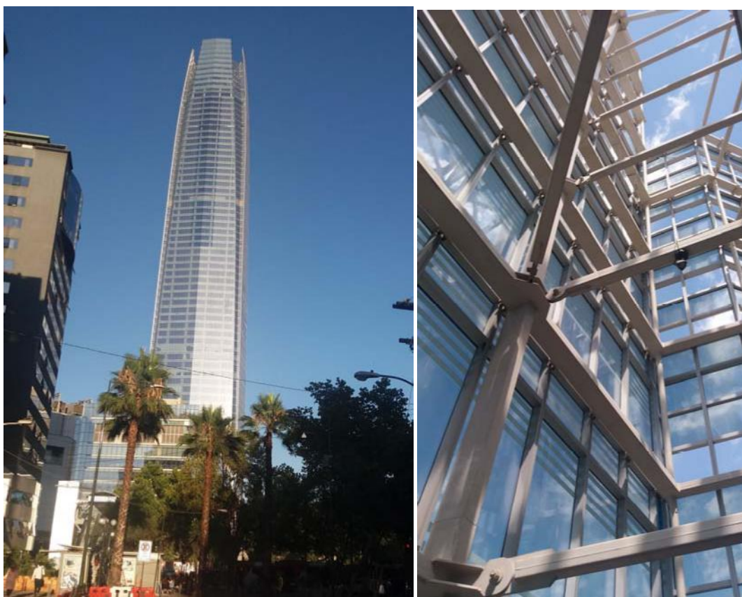
Fig. 1. Turnul principal al Costanera Center. Gran Torre Santiago. Imagine dinspre est (stânga). Structura de legătură dintre fațada cortină și nucleul central în zona superioară (dreapta).
