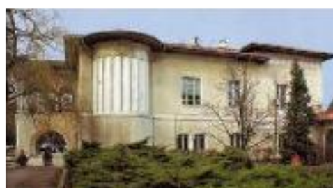
Fig. 8. Vila filosofului Nae Ionescu, București – 1938 – vedere exterioară a absidei decorate cu frize bizantine, în grosimea zidului, înalte și înguste, corespunzătoare la interior biroului; în plan secundar se observă un alt element de arhitectură tradițională – fîșorul (foto iunie 2013 - arhiva prof. dr. arh. Sorin Vasilescu).
