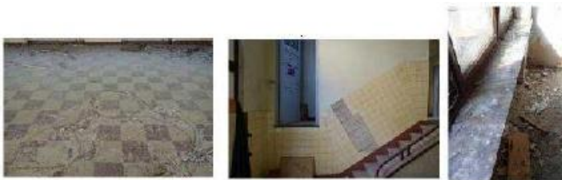
Fig. 1. Auditul pre-demolare (parțial) efectuat înainte de demontarea selectivă a elementelor de construcție recuperabile: gresie ceramică 200 m 2 (dreapta), faianță 140 m 2 (centru), pervaz ferestre (60 ml).
