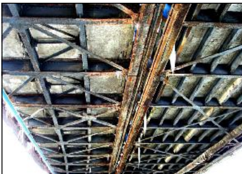
Fig. 3. Dispunerea căii de circulație pe lonjeroane și antretoaze metalice în cazul podului de cale ferată (stânga) și a podului rutier (dreapta).
