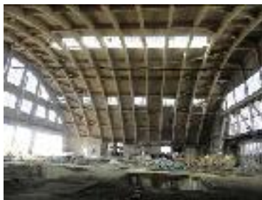
Fig. 5. Hala de montaj IAR – august 2017, vedere interioară a arcelor parabolice și a luminatoarelor (foto - arhiva personală).
