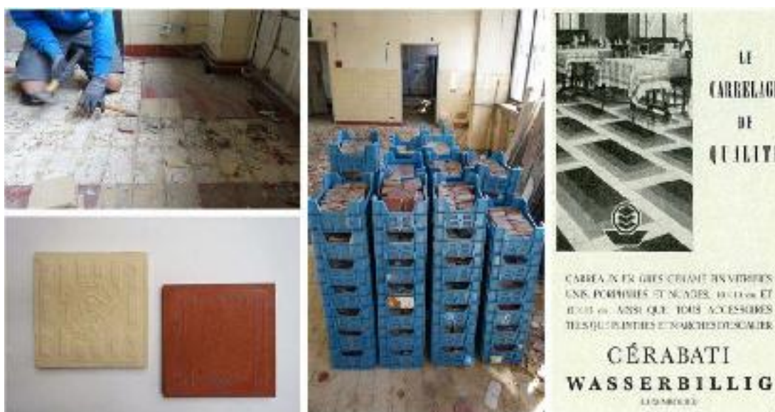
Fig. 2. Acțiuni pregătitoare pentru reutilizare: demontare (stânga sus), transport și curățare (centru), documentare (dreapta) și vânzare (stânga jos).
