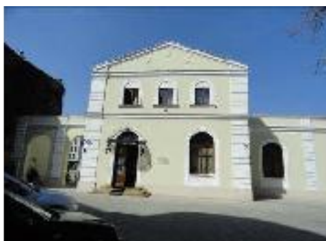
Fig. 2. Jockey Club – Fațada simetrică dinspre strada Episcopiei, prezentând o arcadă formată de două arce în plin cintru care fac trecerea spre curtea interioară dispuse simetric în raport cu volumul principal față de două ferestre semicirculare de la parter (foto aprilie 2016 – arhiva personală).
