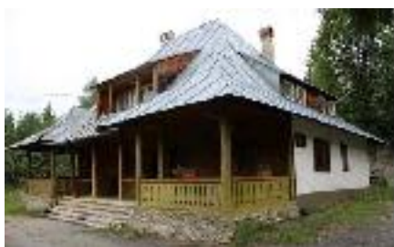
Fig. 7. Casa de vacanță a boierului Guranda din stațiunea Durău, județul Neamț – cca 1938 - vedere de ansamblu a casei dinspre drum, volumetria simetrică și prispă largă cu balustradă și stâlpișori din lemn cioplite cu elemente geometrice, amplasarea pe terenul în pantă a casei; singura construcție din lemn proiectată de GMC (foto august 2019 – arhiva personală).
