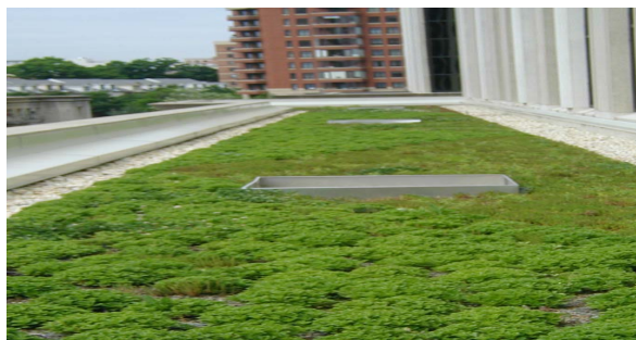
Fig. 4. Toit vert (Source : UACDC, 2010).
