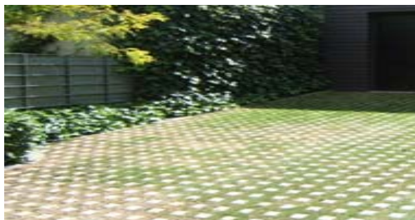
Fig. 5. Revêtement perméable (Source : UACDC, 2010).
