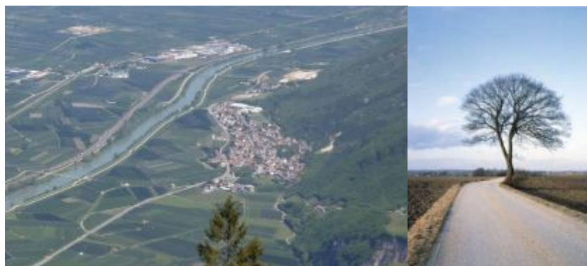
Fig. 2. Stânga - Autostrada A22, Italia, sursa: https://structurae.net/de/medien/366087-autobahn-a-22-italien , Dreapta - Drum de mai mică viteză, sursa: Beautiful Roads - A Handbook of Road Architecture, 2002, Danish Road Directorate, Copenhaga, pag. 7.
